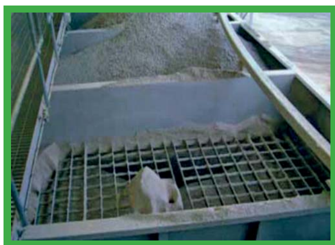
Zainstalowane kraty zabezpieczające.
