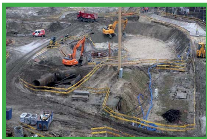
Organizacja transportu na placu budowy.
