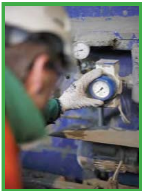
Kontrola mająca na celu sprawdzenie, czy instalacja sprężonego powietrza została całkowicie rozładowana z ciśnienia/odpowietrzona.
