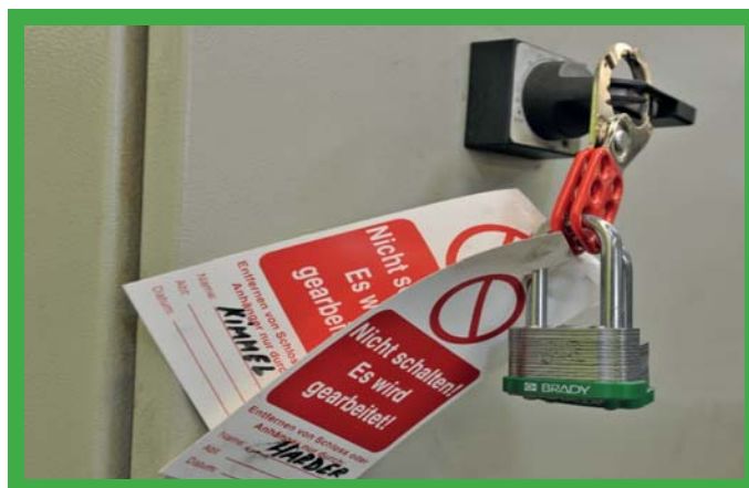
Multiblokada umożliwiająca założenie kilku kłódek.
