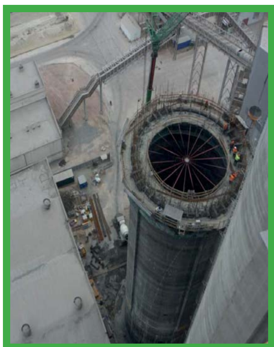
Budowa silosu mączki surowcowej.
