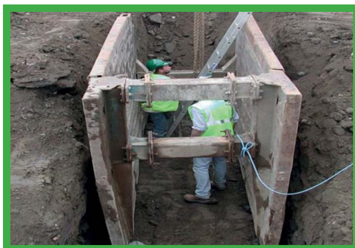
Przykładowe zabezpieczenie ścian wykopu przed obsunięciem.
