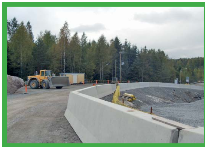
Przykład obwałowania z użyciem betonowych zabezpieczeń.
