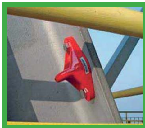
Instalacja punktów kotwienia w wymaganych miejscach.
