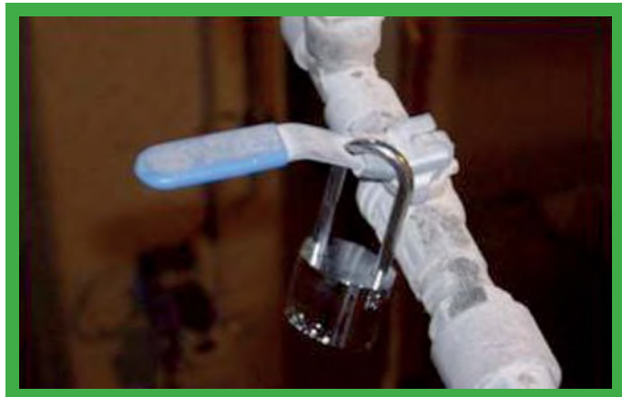
Zablokowanie zaworu energii pneumatycznej.
