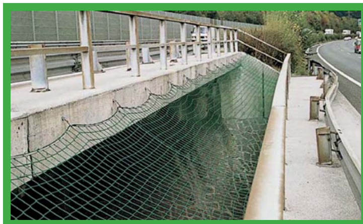
Siatka zabezpieczająca przed upadkiem z wysokości.
