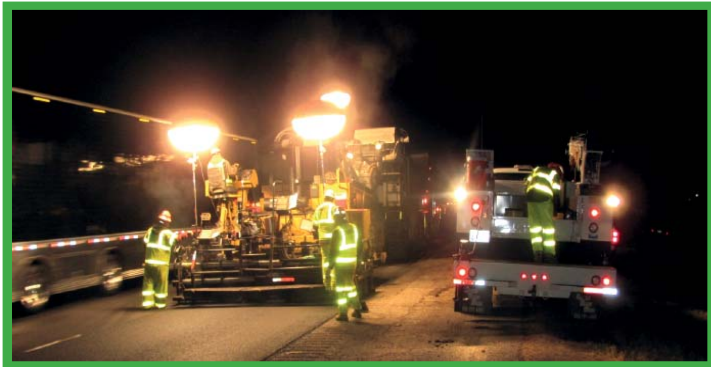
Układanie nawierzchni drogowych nocą podczas ruchu pojazdów.
