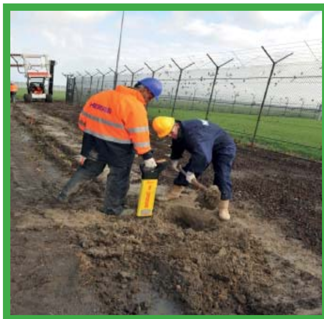
Weryfikacja występowania instalacji podziemnych przed rozpoczęciem prac.
