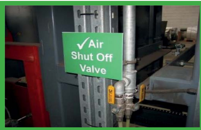
Opis punktu blokowania zaworu energii pneumatycznej.
