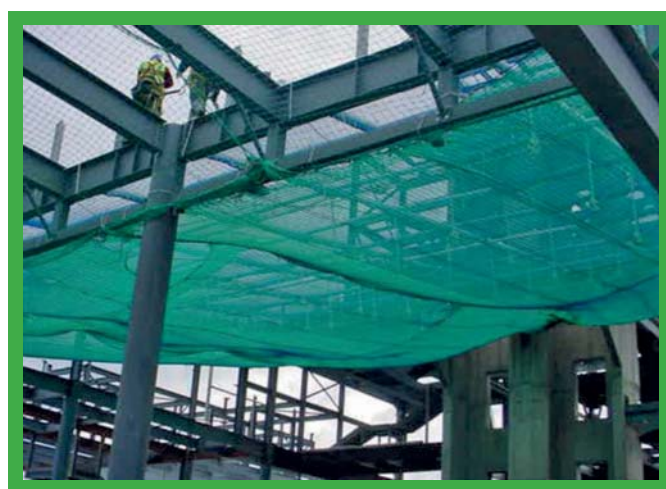
Zamontowana siatka zabezpieczająca przed upadkiem.
